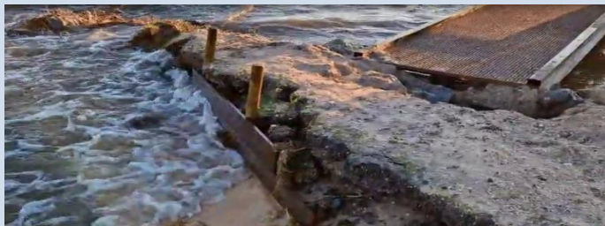
Maandagmiddag 8 januari 2024: Een provisorische golfbreker welke niet bleek opgewassen tegen het water.
